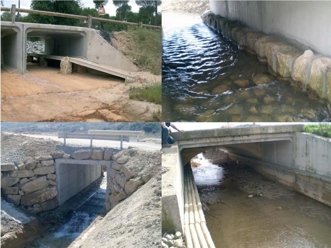
Arriba a la izquierda, plataforma lateral y rampa secas prefabricadas de hormigón, y conexión con orilla (LIFE-LINCE Andalucía). A la derecha, plataforma lateral depiedra de escollera, Falces (LIFE-GERVE). Abajo a la izquierda, plataforma lateral de enchachado de piedra. Barranco de la Torre, Mérida (LIFE-GERVE). Derecha: Repisas laterales de madera tratada. Val del Rey, Carcastillo (LIFE-GERVE).
