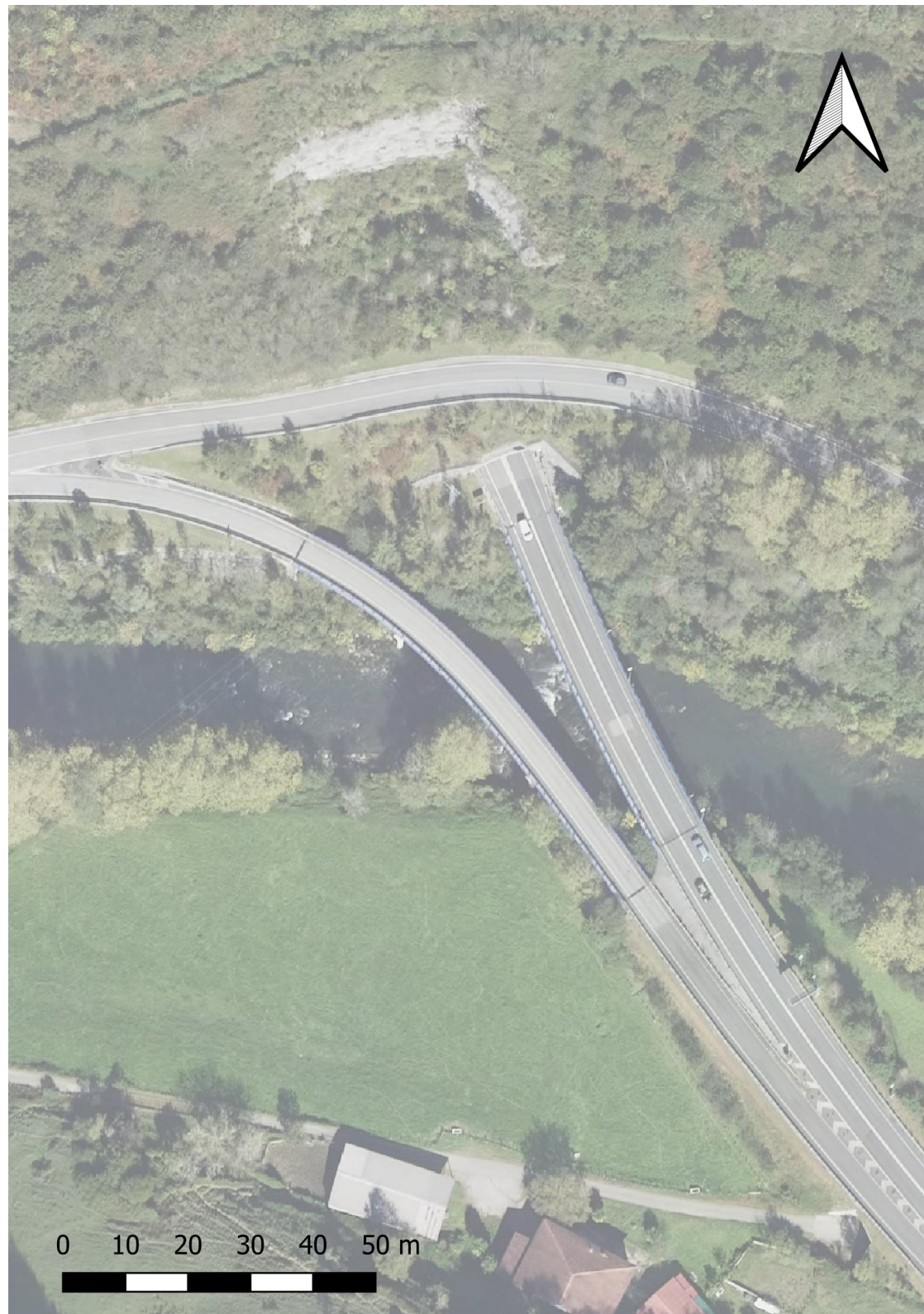
Figura 2.1: Ampliación zona boca sur del túnel Amixelaieta y ladera inestable.
