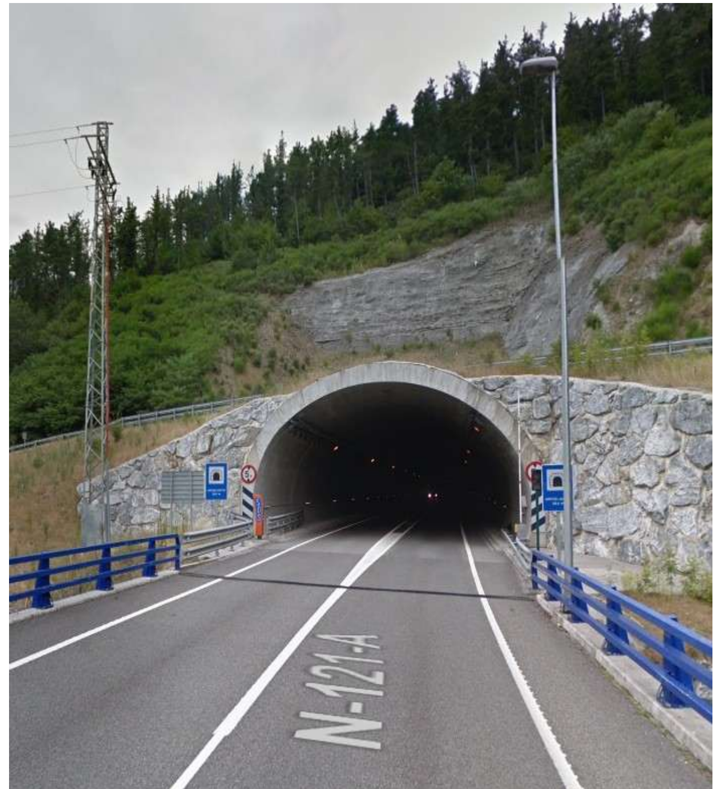
Figura 2.2: Imagen tomada desde el puente de la boca sur del túnel con la ladera a monitorizar detrás.
