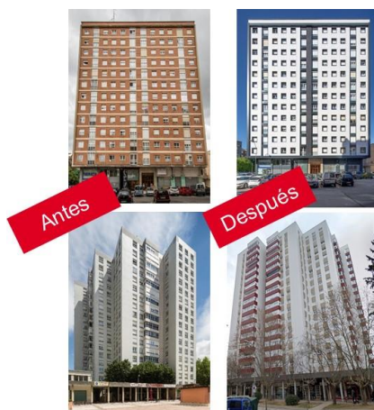
Foto: Estado inicial y final de viviendas rehabilitadas en Pamplona.
