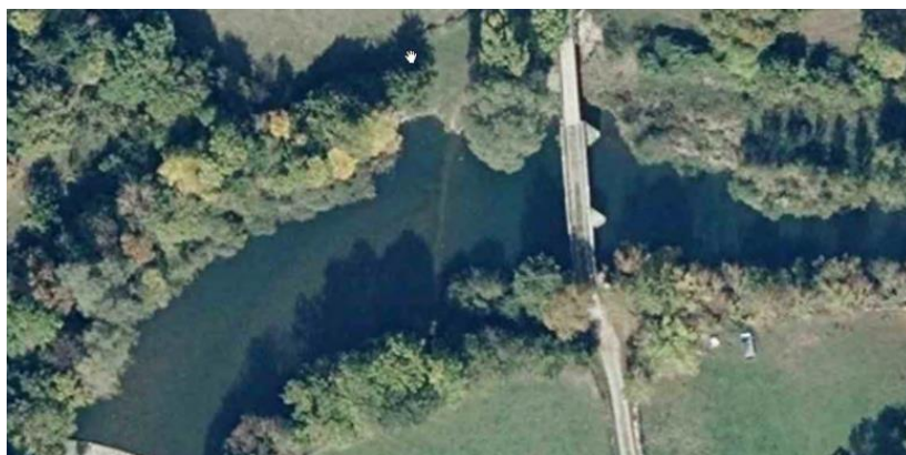
Foto: Proyecto de Restauración de la margen derecha del Río Salazar tras la demolición de la presa del Molino de Oronz.
