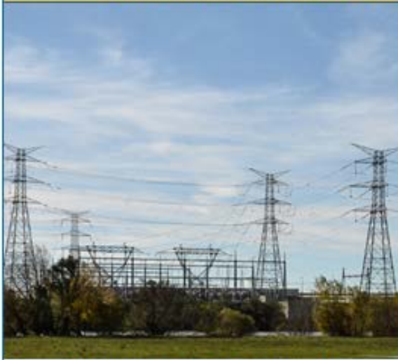
GENERACIÓN DE ELECTRICIDAD
