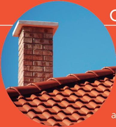
La construcción o reforma de la chimenea debe ejecutarse correctamente, ya que el tiro o conducto de evacuación de los humos -en su trayectoria vertical buscando el exterior- atraviesa forjados y cubiertas que deben estar perfectamente aislados del calor. No aislar una chimenea del forjado o hacerlo de forma deficiente supone exponer a la vivienda a un alto riesgo de incendio.
