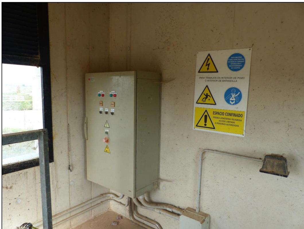
**Ilustración 39.** Imágenes de las estaciones de bombeo a la salida de la EDAR. Estas estaciones, con bombas instaladas de forma permanente, permiten bombear sorteando la altura de la mota, el agua acumulada en caso de crecida del Ebro.
