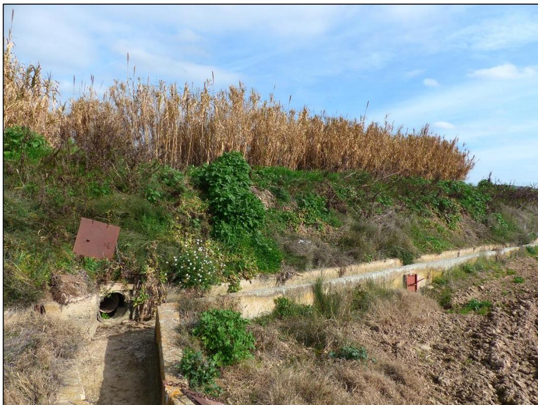
**Ilustración 45.** Ejemplo de tajaderas que deben cerrarse antes de que la inundación del Ebro alcance la base de la mota. Algunas de estas tajaderas permanecen atadas con cadenas para evitar su robo.
