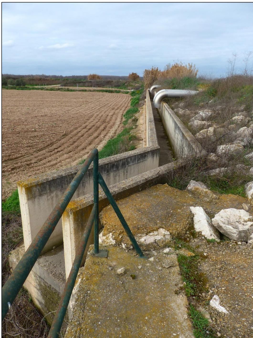
**Ilustración 40.** Canal diseñado para verter al río Ebro, en situación de crecida, las aguas acumuladas tanto de la salida de la EDAR, como el agua acumulada en las acequias. Al fondo se observan los 4 tubos a través de los que se bombea el agua acumulada al otro lado de la mota.
