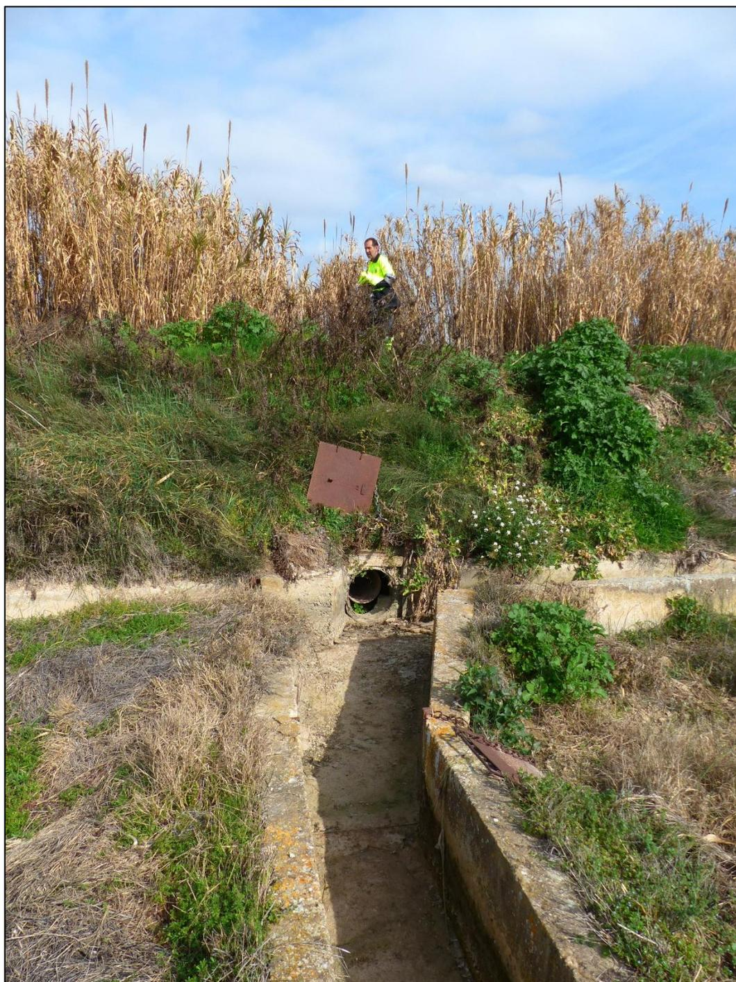
**Ilustración 46.** Imagen de tajadera que debe cerrarse para evitar el paso del agua del Ebro al otro lado de la mota, y para evitar que de ese modo se inicie la inundación de los campos cultivados al otro lado de la mota, en dirección al casco urbano de la localidad. La altura de la propia mota se observa teniendo como referencia al operario municipal que se encuentra sobre ella.
