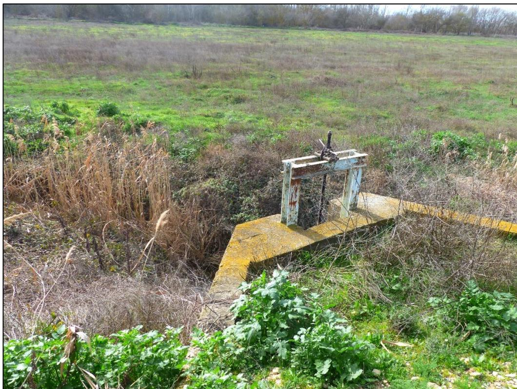
**Ilustración 48.** Acequias (imagen superior) en la zona norte del municipio, discurriendo en paralelo a la mota. Abajo, detalle de una de las tajaderas que en esta zona deben ser cerradas para evitar la inundación de amplias zonas del municipio.
