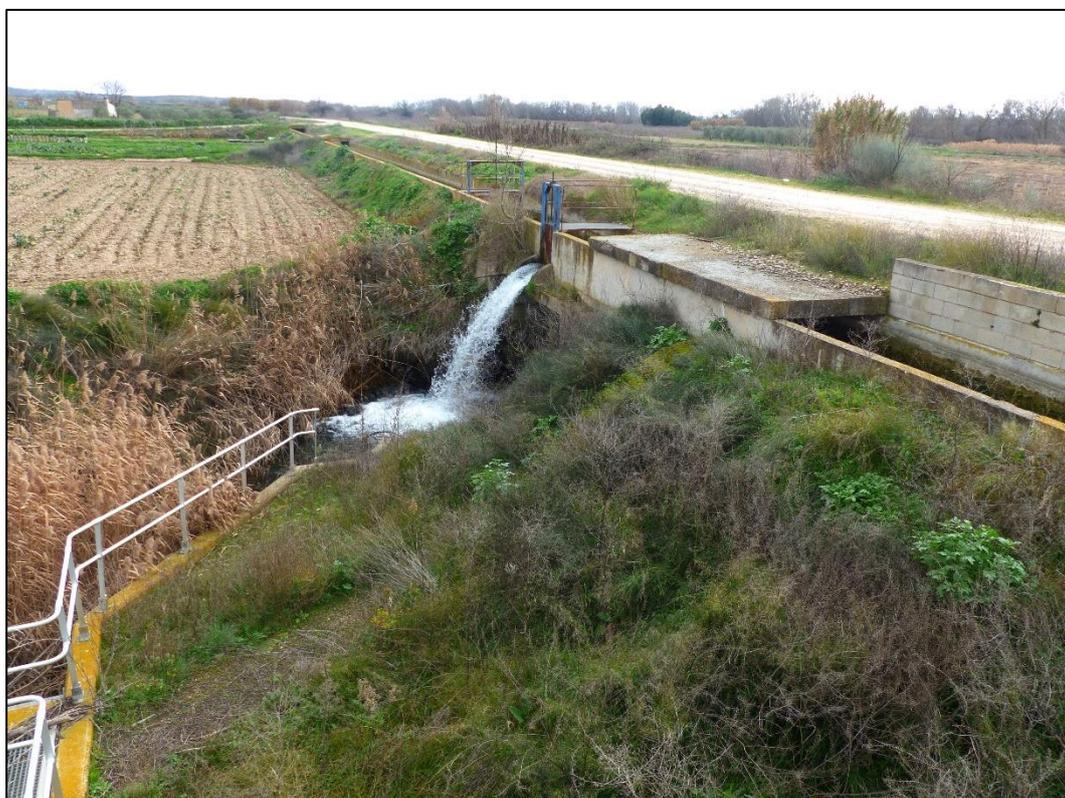
**Ilustración 38.** En la imagen superior, sección típica de la mota, con un importante desnivel sobre ambos lados de la misma, como se observa en ambas imágenes. La acequia principal discurre en paralelo a la mota, permitiendo desaguar hacia los bombeos a la salida de la EDAR (foto inferior).
