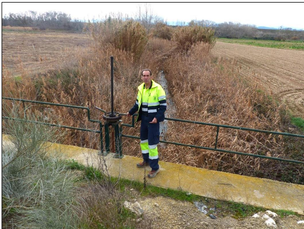
**Ilustración 42.** Tajadera en la mota a la altura de la EDAR. Tajadera de gran importancia, ya que su cierre es la primera acción a realizar en el municipio en caso de crecida del Ebro.
