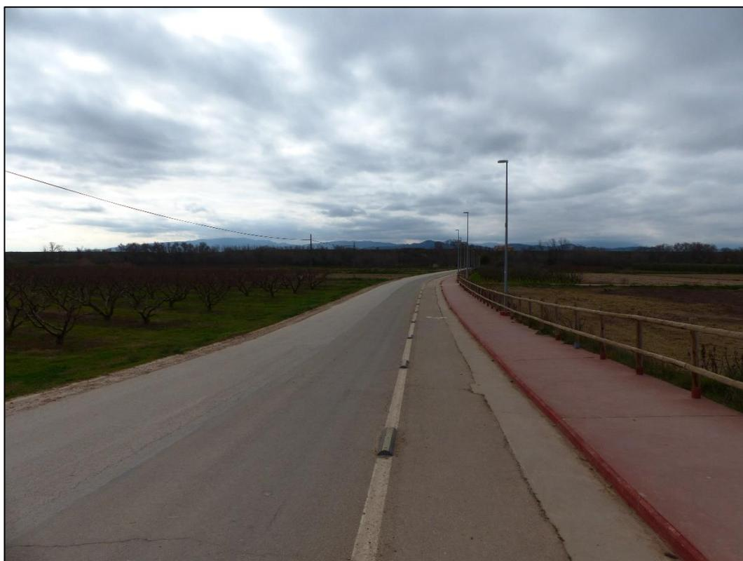
**Ilustración 37.** Paso sobre-elevado de la carretera que une el casco urbano con La Barca de Azagra, para salvar la elevación provocada por el cruce con la mota. En la imagen inferior se muestra el tramo que se dirige al río Ebro, y que con frecuencia resulta parcialmente inundado.
