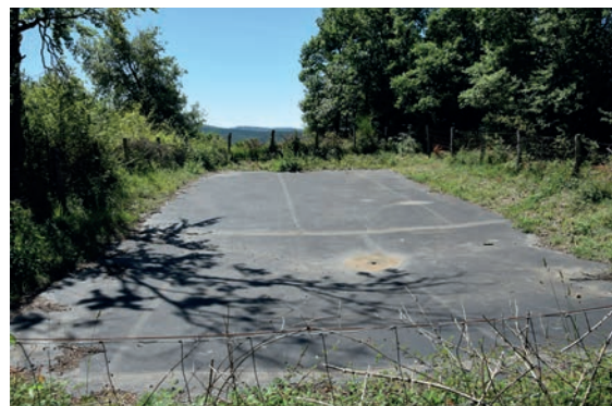
↑ Balsa de recepción conectada a depósito de almacenaje de hormigón.
