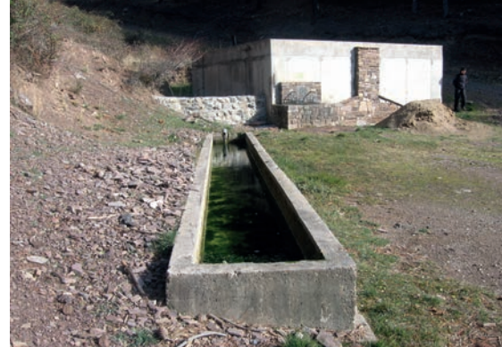
↑ Abrevadero conectado a depósito que incluye boca incendios.
