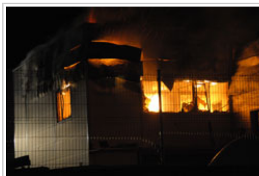
El fuego ha afectado a la totalidad de las instalaciones.
