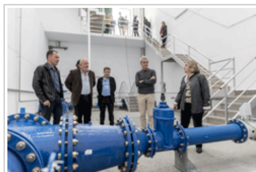
Interior del depósito.
