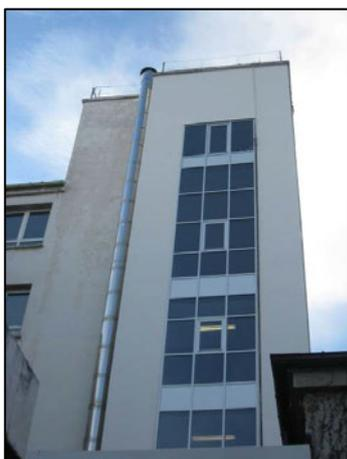
Además se han ejecutado mejoras relacionadas con las envolventes de los edificios como la sustitución de ventanas por otras de doble acristalamiento y rotura del puente térmico o la sustitución de cubiertas incorporando mejores sistemas de aislamiento.
