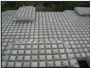
Por otro lado el edificio está diseñado de manera que el aporte de luz natural es muy elevado gracias a la instalación de claraboyas en todos los techos, sin embargo este tipo de cerramientos se encuentra en un estado de conservación deficiente y el gasto energético es muy elevado debido a las pérdidas de calor que se producen a través de estos elementos. En la actualidad se está proyectando una solución técnica para la solución del problema existente.
