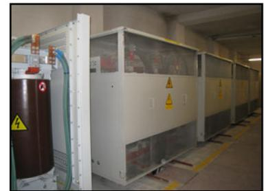
Existe un gran centro de transformación situado en el sótano del edificio general, equipado con 5 transformadores:
