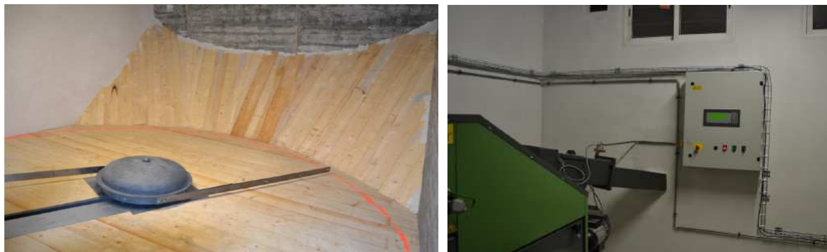
Imagen 29. Instalación del Hotel Venta Etxalar
