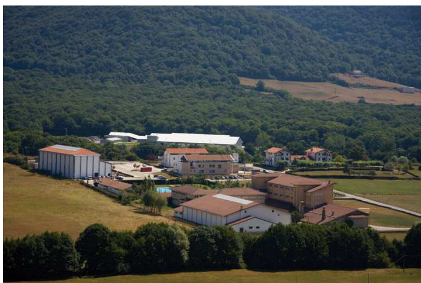
Imagen 3. Edificios suministrados por la red de calor municipal. Larraintzar (Ultzama)
