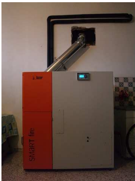
Imagen 15. Instalación de una vivienda unifamiliar en Olite
