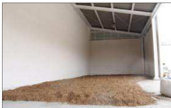
Imagen 25. Almacén de combustible del Aula de la Naturaleza - Naturgela. Berriozar
