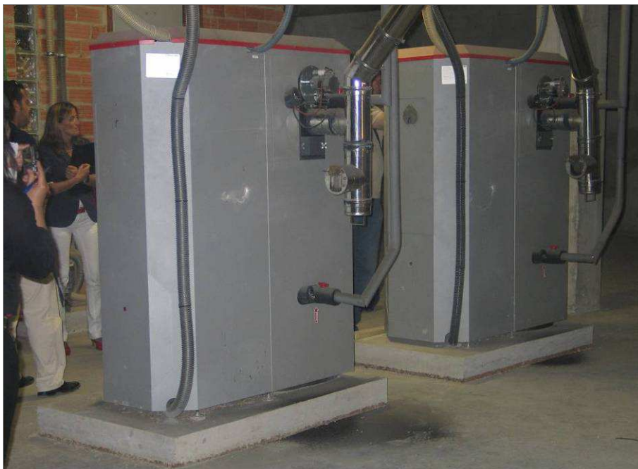
Imagen 20. Instalación de la escuela infantil municipal en Noáin
