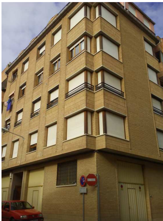
Imagen 12. Edificio de la calle Roncesvalles, 1-3 (Peralta).
