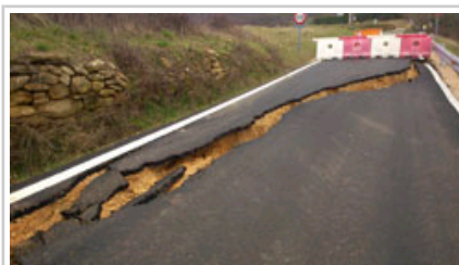
Imagen del hundimiento de la calzada en el acceso a Arzo.
