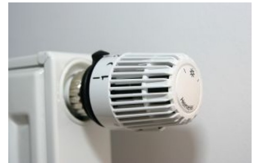
Ejemplo de válvula termostática en un radiador.
