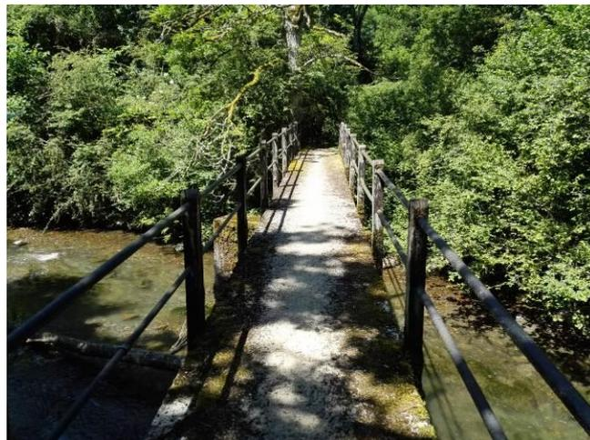
Foto nº 19. Pk 37+020. Ederbidea en el punto en que cruza el río Basaburua en el robledal de Gartzaron. Se repondrán las barandillas y se acondicionará la losa de hormigón existente.
