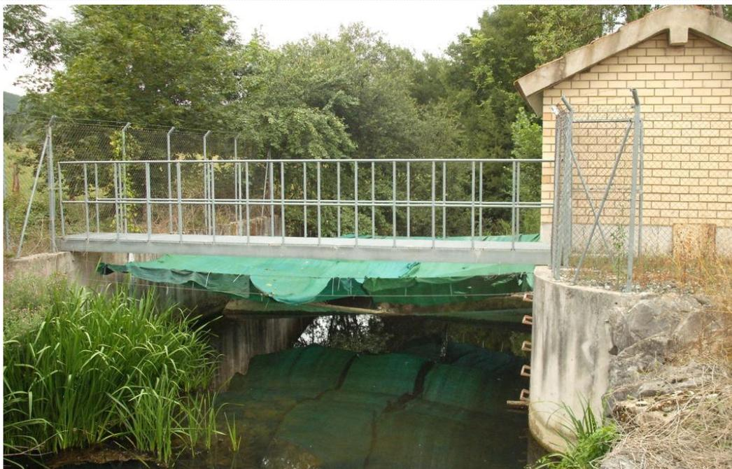
**Fig. 4.6.4. Estación de Oskotz en aguas bajas con escasa circulación de agua, lo que intensifica el efecto del estiaje en la calidad de agua. Detalle de la lona para reducir la insolación en la época cálida.**
