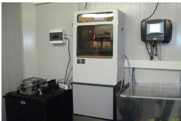
**Foto. 1.2. Interior de una Estación SAICA: cubeta de medición, controlador y tomamuestras.**
