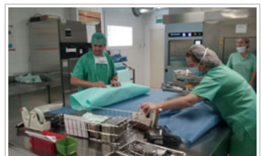
Instalaciones de esterilización de instrumental en el Hospital de Estella.
