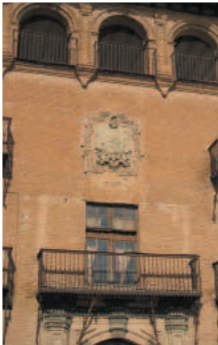
Corella. Casa de los Virto de Vera. Plaza de los Fueros. Construida en 1741 por Juan Fermín Virto de Vera-Azpilcueta y Larreta.
