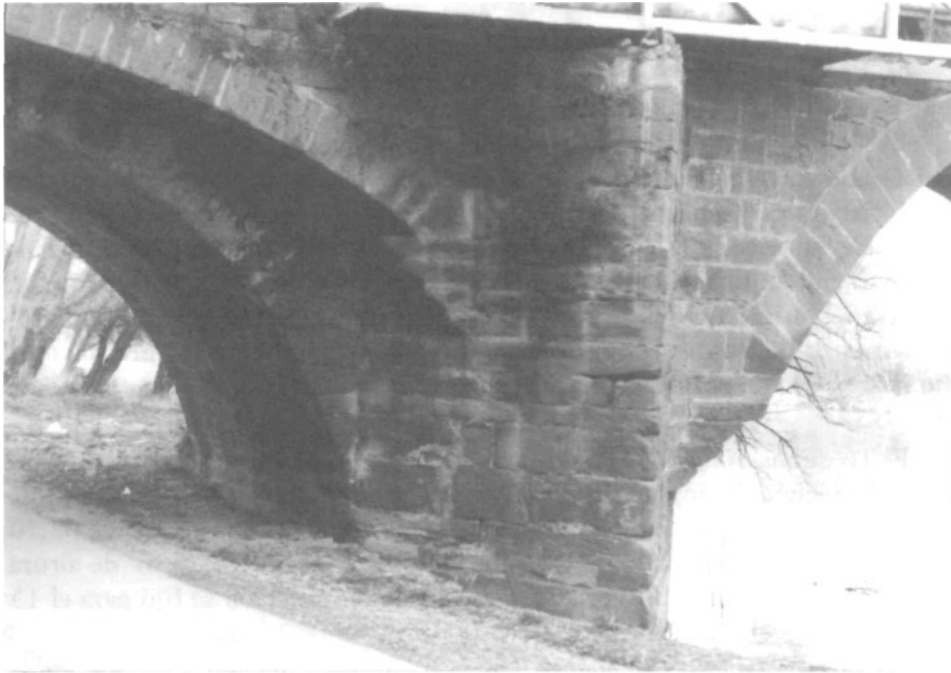
Detalle del puente.
