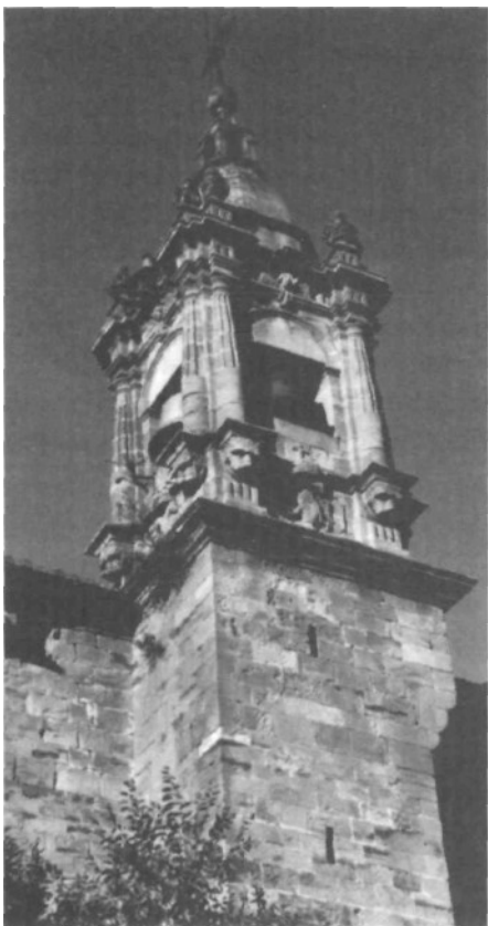
Torre del campanario.
