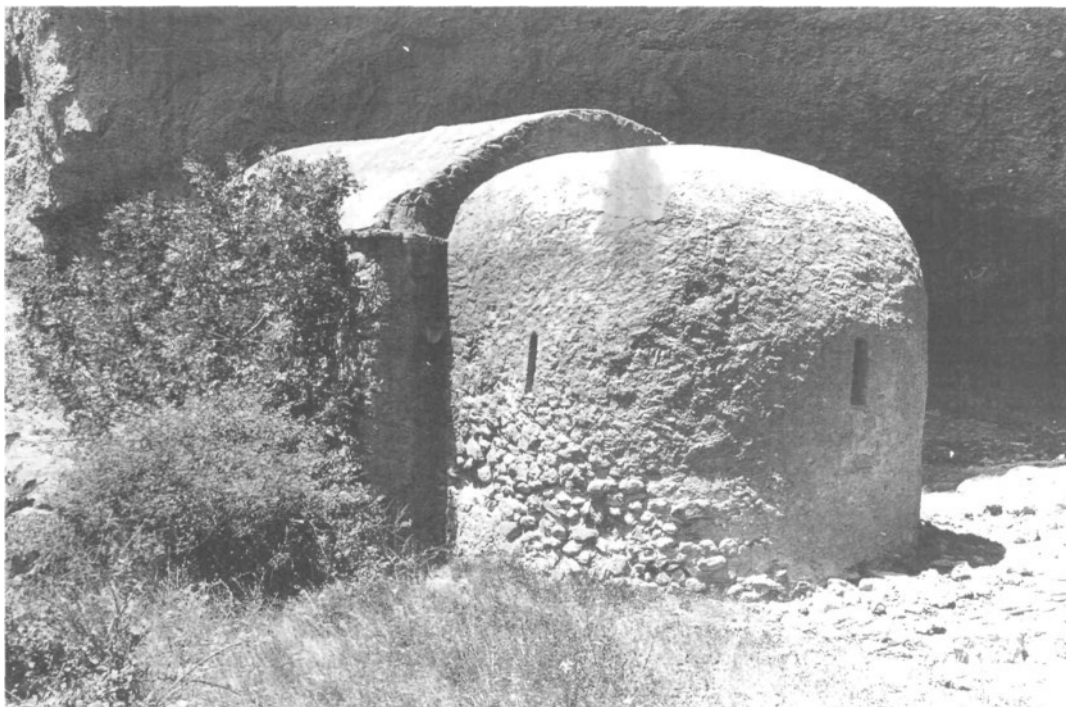
fot. 2.-San Esteban. Exterior de la iglesia desde el sureste. La diferencia de materiales y paramentos denuncia las varias refacciones del templo.
