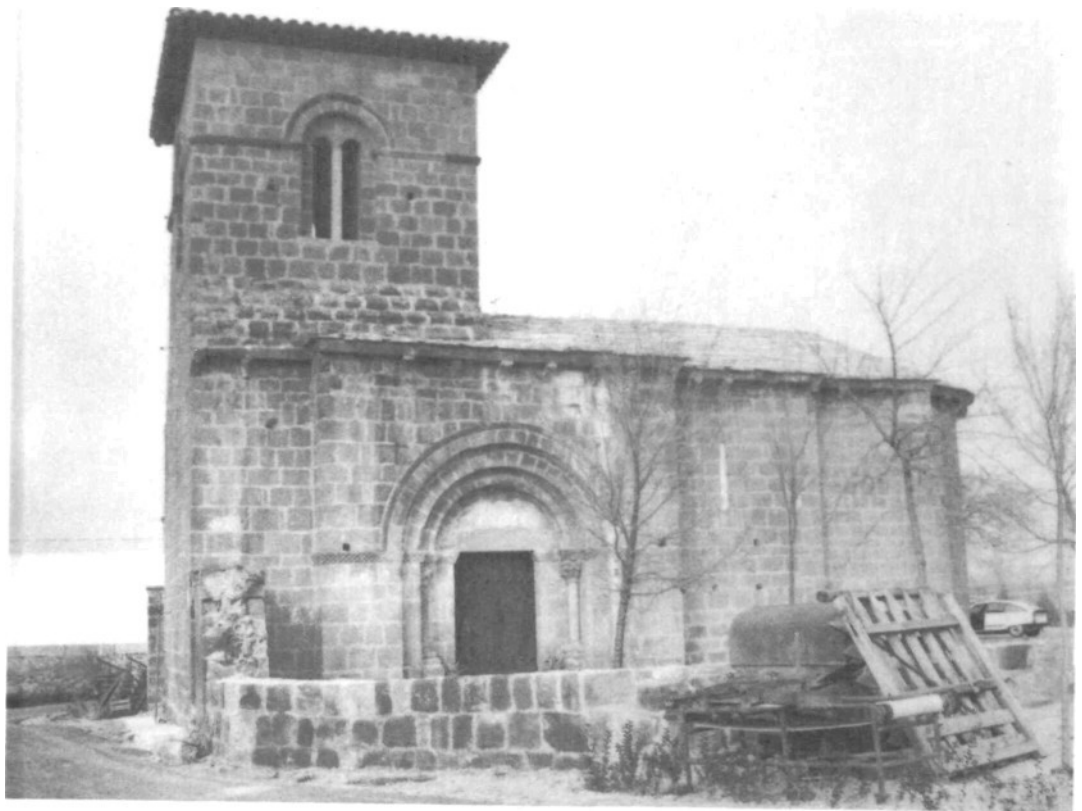
Fachada sur restaurada.
