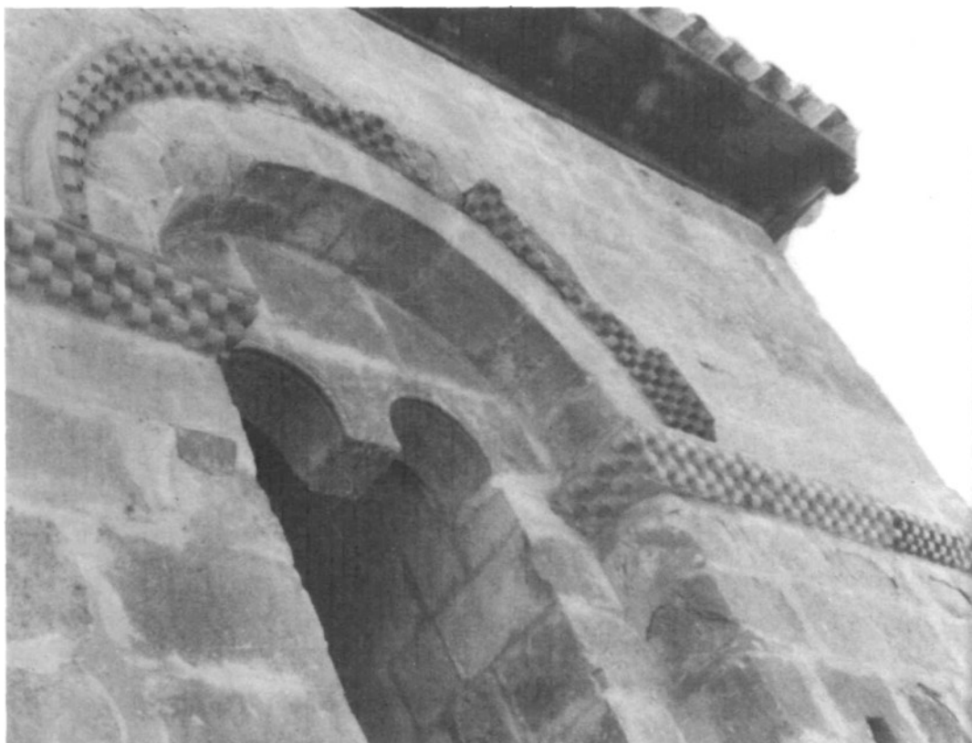
Detalle de una ventana de la torre.
