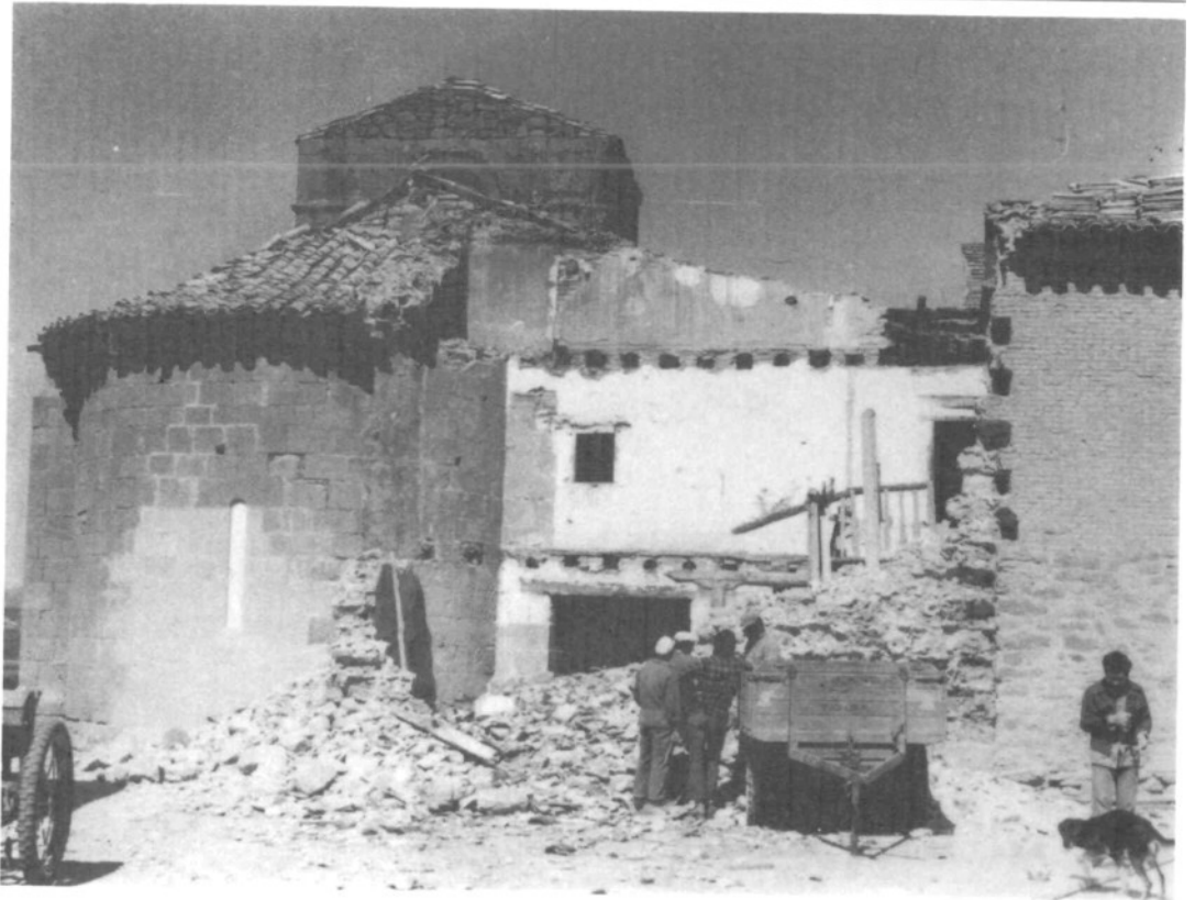
Derribo del edificio adosado.
