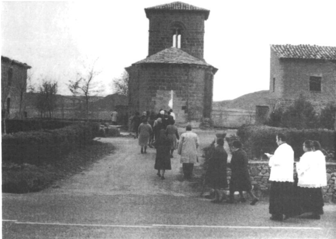
Vista desde la carretera, después de la restauración.
