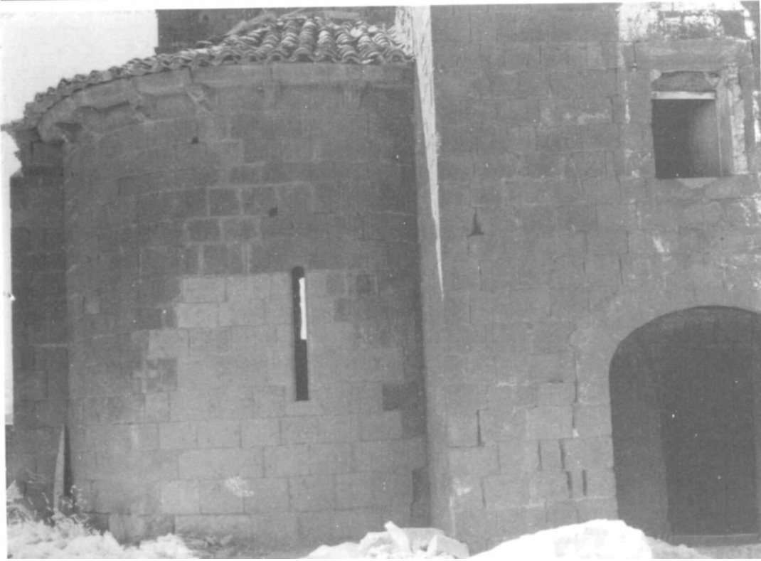
Ábside antes de derribar el edificio adosado.
