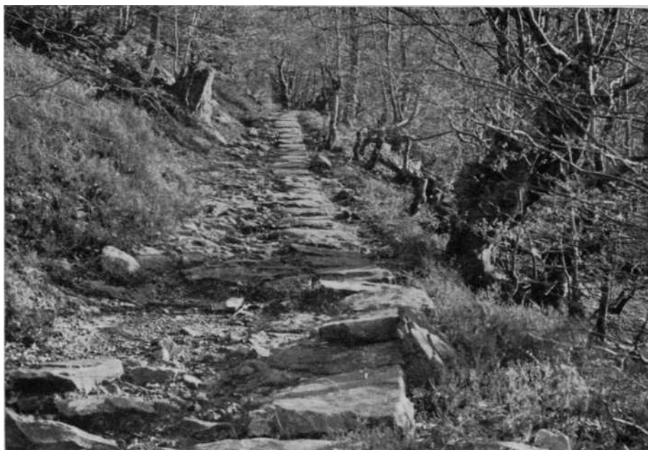
Foto 15.—Trozo de calzada al pie de las peñas de Sustera, a uno 560 metros s. n. m., visto del N.
