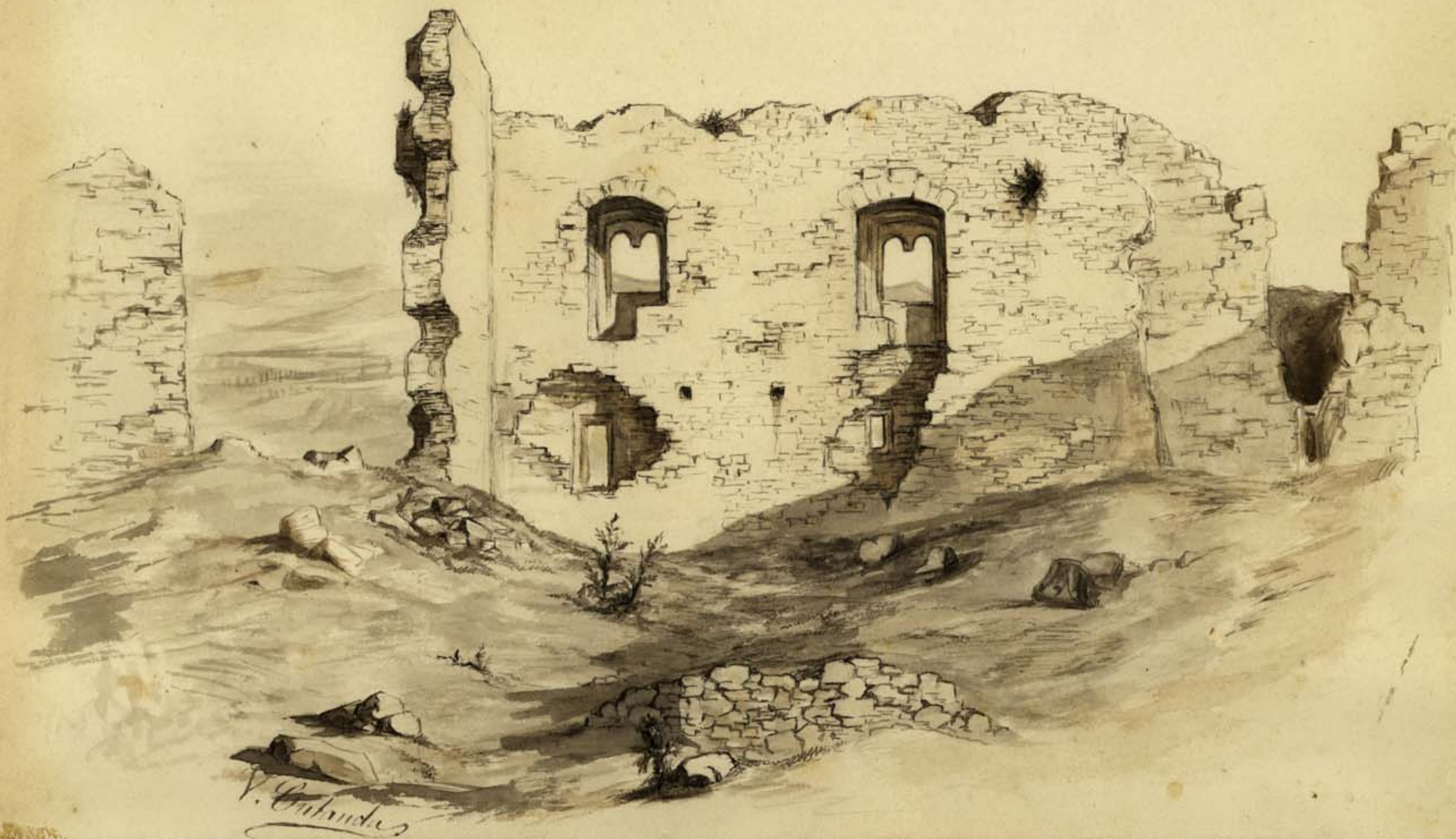
Castillo de Lizur - Ruinas del patio central, vistas del lado E.
