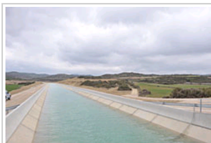
Primera fase del Canal de Navarra, a su paso por Pitillas.
