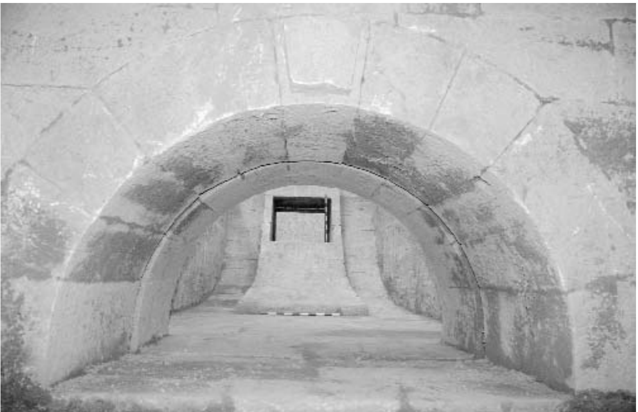
Foto 7. Presa de la Serna 94.
