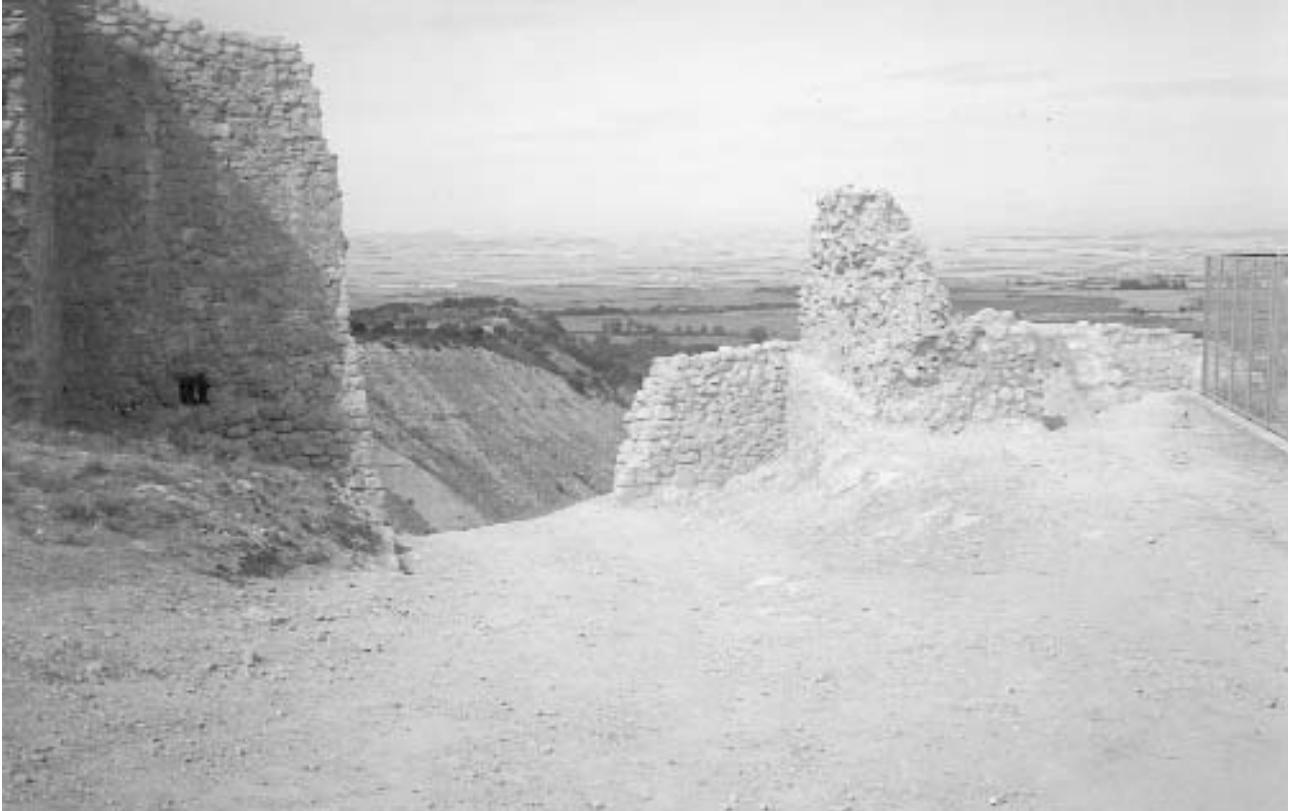
Foto 3. Rada 1995. Consolidación de la muralla.
