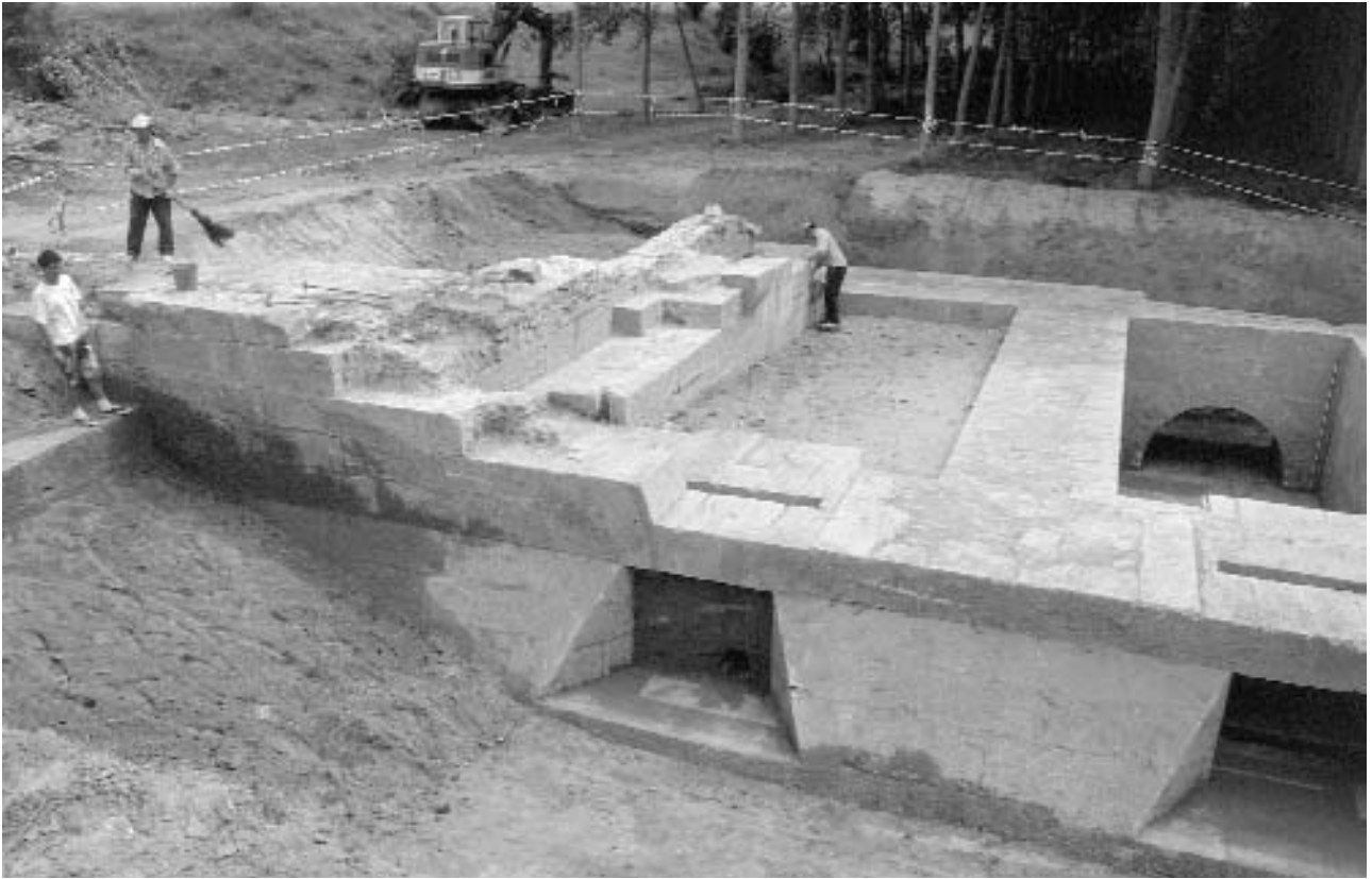
Foto 1. Presa de la Serna 94.
