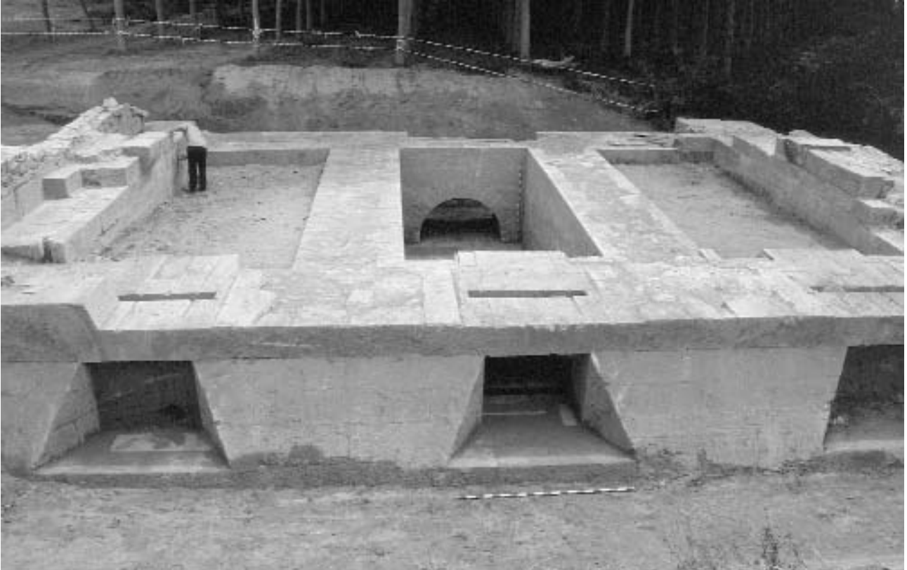
Foto 2. Presa de la Serna 94.
