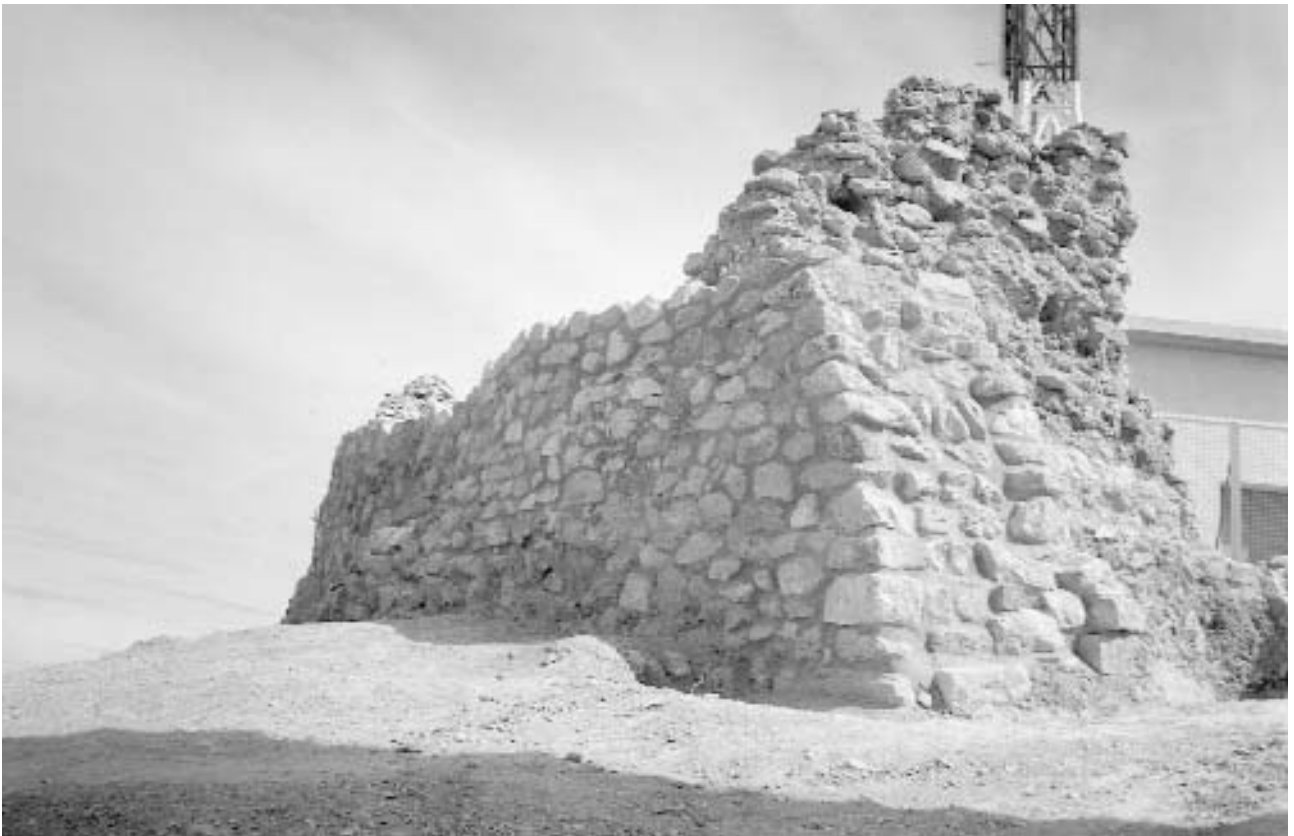
Foto 4. Rada 1995. Consolidación de la muralla.
