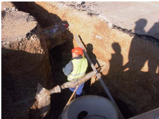
La Dirección Facultativa o Técnica de la obra deberá determinar, en función de las características físicas y mecánicas del terreno y del estudio geotécnico del mismo, los sistemas de protección interior de la zanja o pozo, teniendo en cuenta las posibles sobrecargas estáticas y dinámicas debidas a la existencia de viales y maquinaria, presencia de cimentaciones o edificaciones colindantes, arquetas antiguas, colectores y almacenamiento de cargas y materiales.
