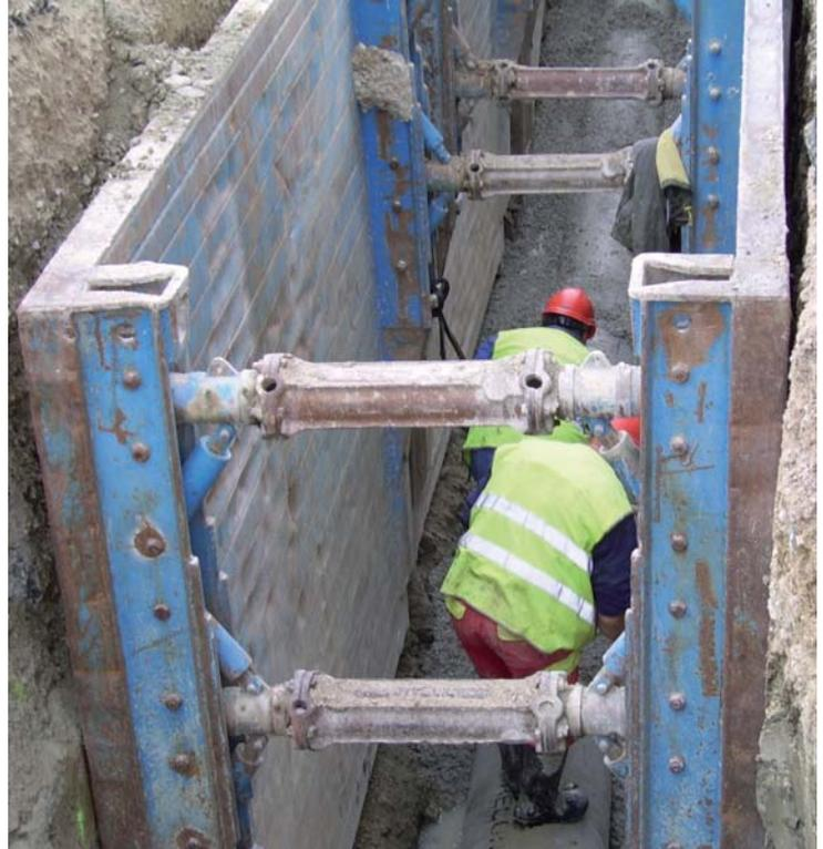
La colocación y renovación de redes de distribución, canalizaciones de agua, desagües, drenajes, conducciones de gas, electricidad y comunicaciones, así como la ejecución de cimentaciones tradicionales y especiales en edificación, exigen la excavación longitudinal o puntual de tierras, más o menos estrecha y profunda bajo la rasante del terreno, recibiendo la denominación de zanja o pozo.
