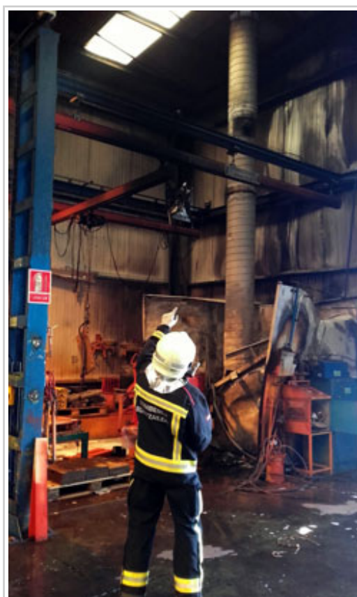
Un bombero revisa la zona afectada por el incendio.
