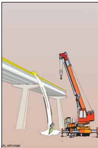
O ofício de Colocador de Pré-fabricados na construção de pontes, viadutos e passagens elevadas, traz consigo as operações de montagem de vigas pré-fabricadas, lajes de betão, cofragem e descofragem, colocação de armações, betonagem da placa, colocação de impostas, corrimões, realização de remates e acabamentos exteriores.
