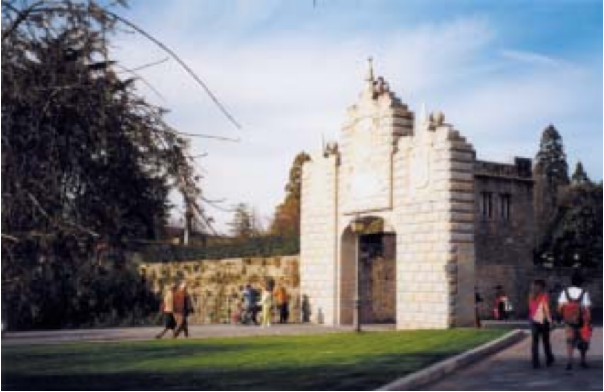
Puerta de la Taconera restaurada en 2006 . Bajo el puente levadizo de acceso se acumulaban las fécales que llegaban desde la Ciudadela. Hoy parque acuático instalado en 1973.
