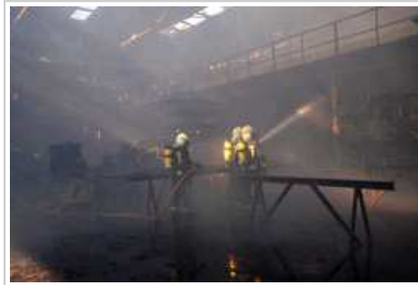
Los daños son muy importantes.
