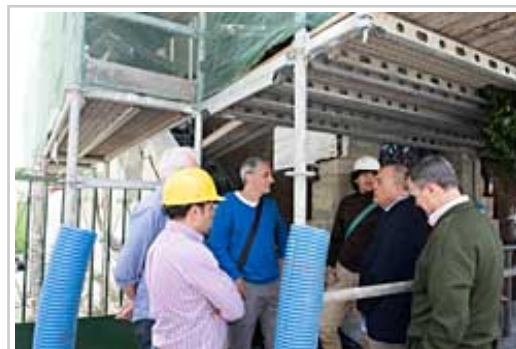
El consejero Zarraluqui visita las obras para instalar la envolvente térmica.
