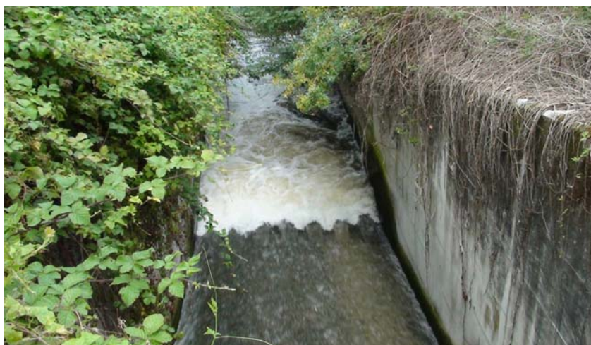
Figura 1.2. Vista de detalle de la estructura de salida del efluente de la EDAR.
