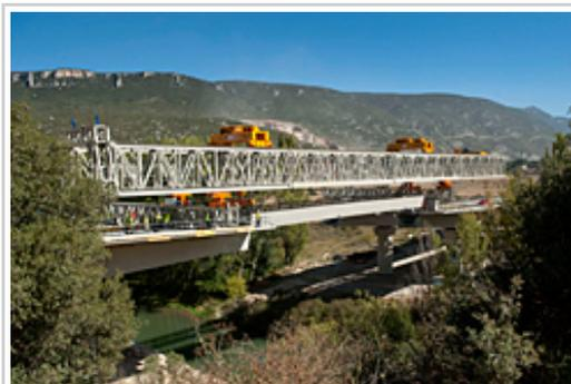
Colocación del viaducto sobre el río Irati durante las obras de construcción de la Autovía del Pirineo (A-21).
