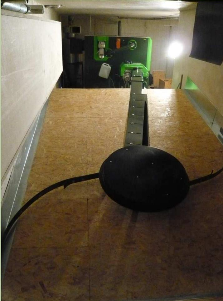
La producción de calor en las instalaciones de Isaba se consigue mediante una caldera de biomasa de potencia 350 kW, utilizando pellet como combustible.
