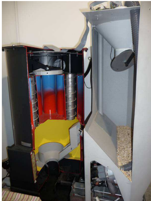
Figura 3. Detalle de una caldera de pellets.
