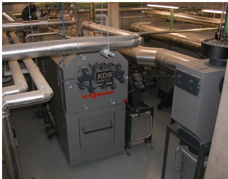
Figura 2. Equipo de generación de calor con biomasa en la Comunidad de San Juan Bautista, Tudela. Fuente: CENER.
