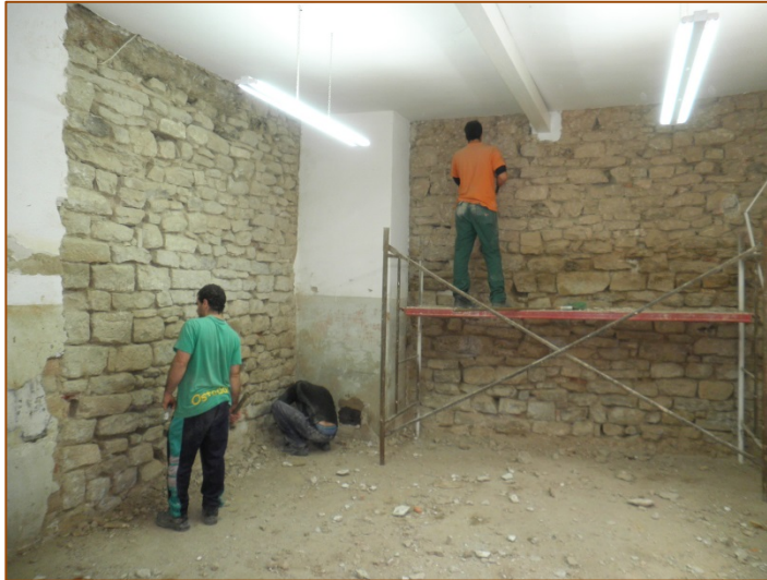
Armañanzas – Adecuación de local para usos sociales
