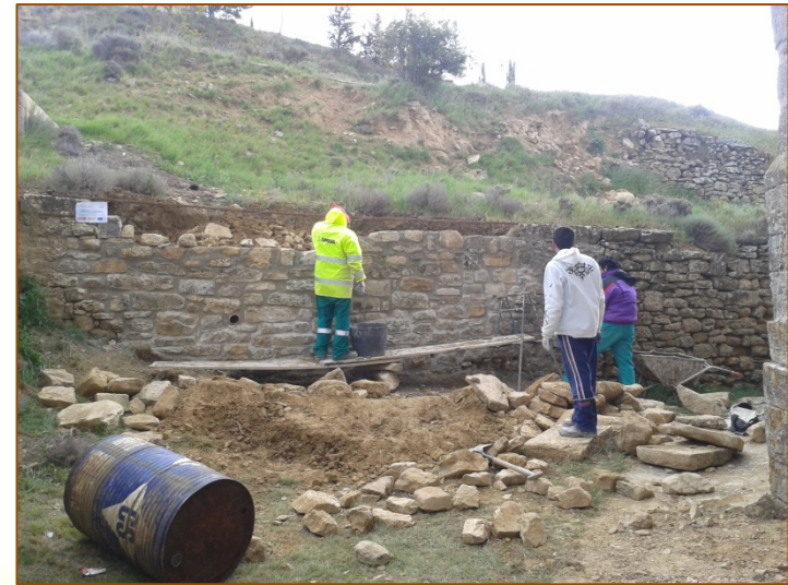
Barbarin – Mejora del muro de la iglesia
