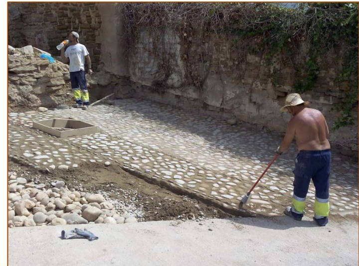
Lodosa – Empedrado de calle en el casco antiguo
