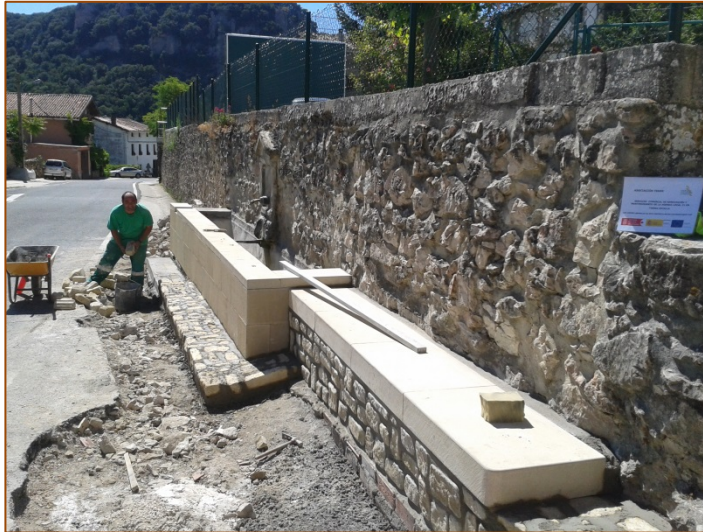
Galbarra (Lana) – Arreglo y reconstrucción de fuentes
