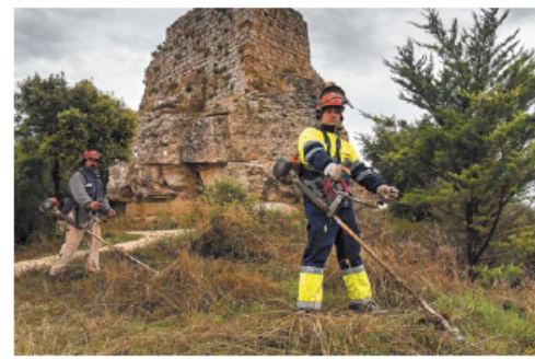
Trabajos en Villamayor de Monjardín, donde se desbroza este día en el entorno del castillo.
