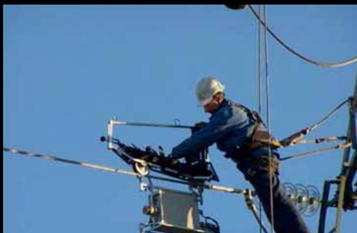
FIG. 7: COLOCACIÓN DE LAS BALIZAS SALVAPÁJAROS ("X" DE NEOPRENO) MEDIANTE ROBOT GUIADO EN LA ZONA DE PROTECCIÓN DE LOS MONTES DE LA VALDORBA.
