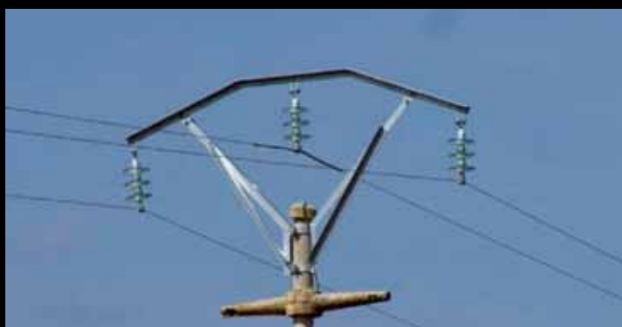
FIG. 13: ANTIGUO APOYO DE ALINEACIÓN CORREGIDO SIGUIENDO LOS CRITERIOS DE LA NUEVA NORMATIVA NACIONAL (RD 1432/08). SE HAN SUPRIMIDO LOS AISLADORES RÍGIDOS, SE HA REINSTALADO UN NUEVO ARMADO EN BÓVEDA Y SE HA AISLADO LA FASE CENTRAL CON CUBIERTAS DE SILICONA.
