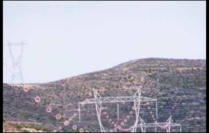
FIG. 6: TENDIDO DE TRANSPORTE (220 KV) CON LOS HILOS DE TIERRA SEÑALIZADOS CON BALIZAS SALVAPÁJAROS (ESPIRALES CERRADAS) PARA EVITAR ACCIDENTES POR COLISIÓN EN UNA ZONA DE PROTECCIÓN DE LA AVIFAUNA.
